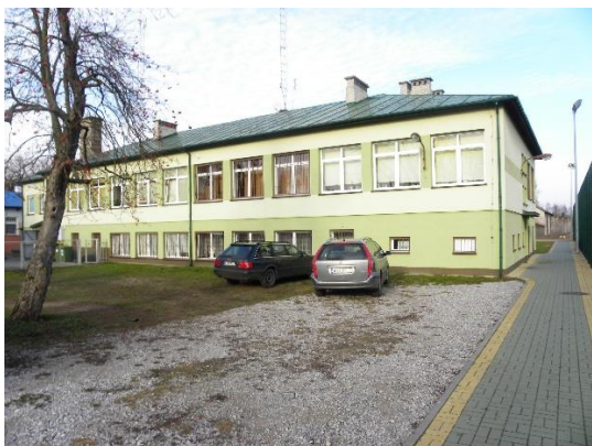
Budynek Gimnazjum w Domanicach – Kolonii
