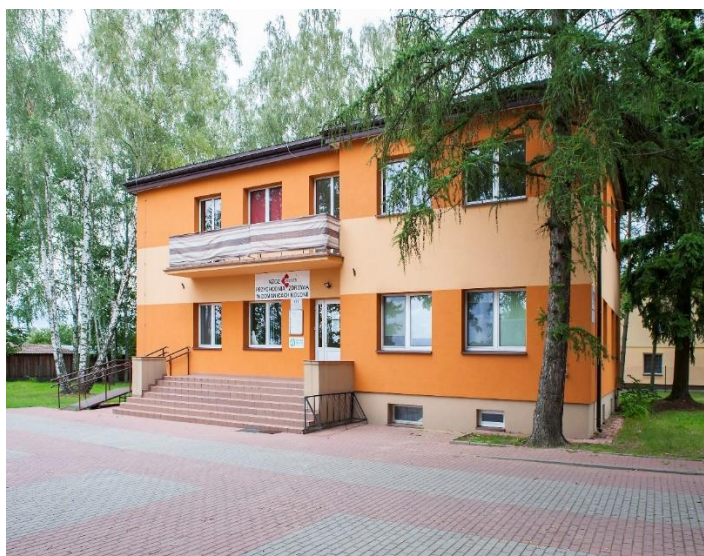
Budynek Przychodni Zdrowia w Domanicach - Kolonii
